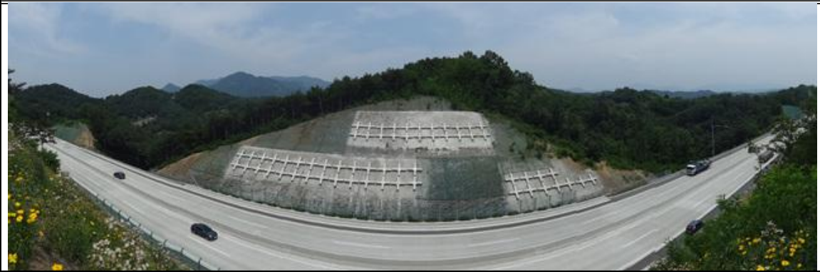
상주절토 49 (관리이정 71.058~71.198km / 8공구 STA.5+700~5+840)
