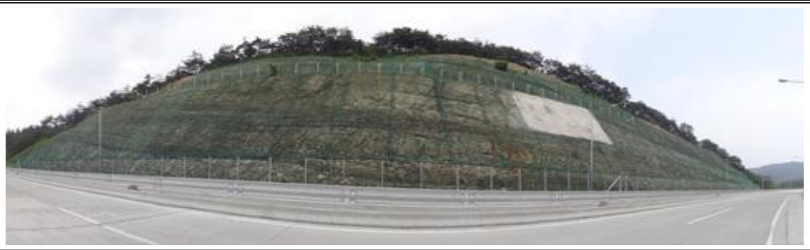
상주절토 35 (관리이정 0.160~0.42km / 6공구 STA.0+160~0+420(이설도로#2))
