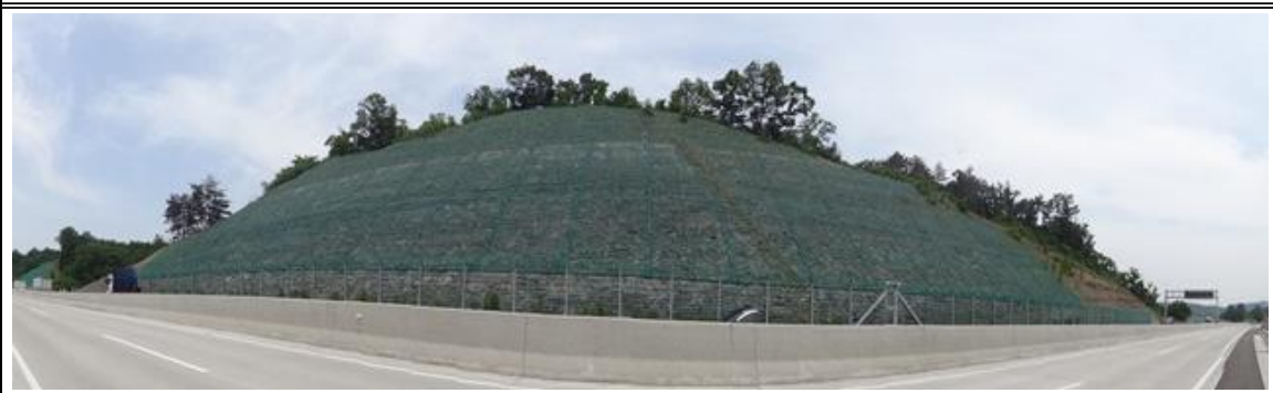
상주절토 50 (관리이정 71.71.478~71.718km / 8공구 STA.6+120~6+360)
