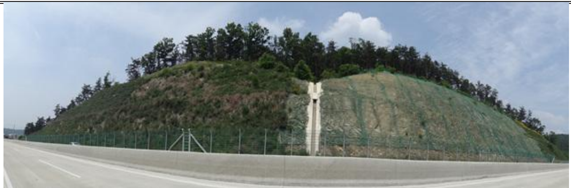
상주절토 8 (관리이정 14.074~14.334km / 2공구 STA.6+680~6+940)
