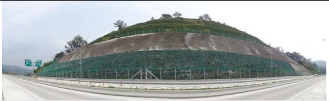
영천절토 34 (관리이정 1.890~2.150km / 5공구 군위R-A(중앙)STA.1+890~2+150)
