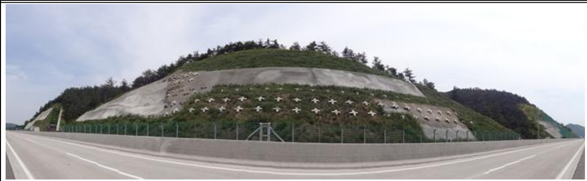
상주절토 42 (관리이정 58.638~58.798km / 7공구 STA.3+080~3+240)
