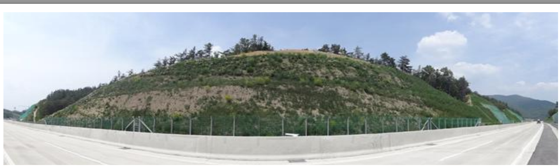
상주절토 11 (관리이정 15.894~16.014km / 2공구 STA.8+500~8+620)
